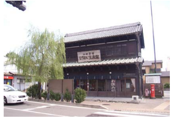
旧網問屋を改修して設けた休憩施設
