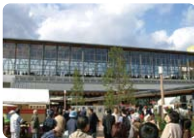
地域のシンボルとなる駅舎 及び駅前広場の整備
