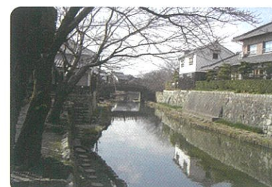
浚渫と修景による歴史的な堀の保存・再生
